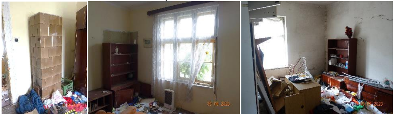
Prízemie – schodište do podkrovia z kuchyne, podkrovia, izba v podkroví
